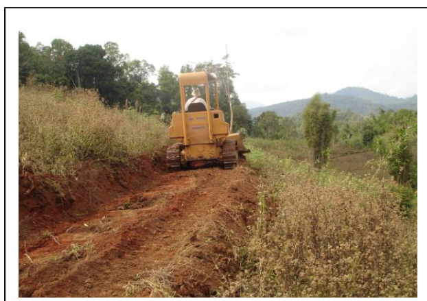
ภาพที่ 31 การก่อสร้างระบบอนุรักษ์ดินและน้ำโดยใช้เครื่องจักรกล
