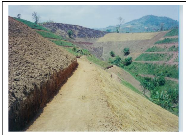
ภาพที่ 36 คูรับน้ำขอบเขา (Hillside ditch)
