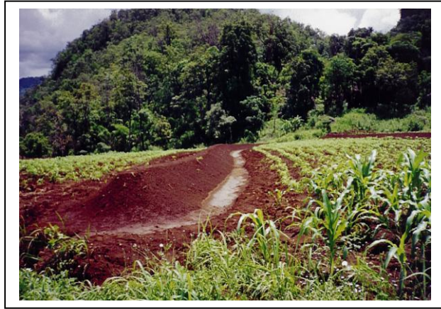
ภาพที่ 34 คันดินกั้นน้ำ (Broad base terrace)
