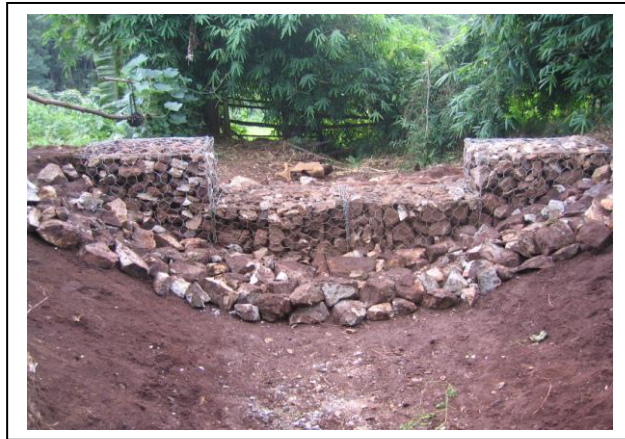
ภาพที่ 40 อาคารชะลอความเร็วของน้ำโดยใช้กล่องเกเบี่ยน
