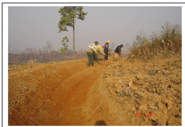
ภาพที่ 33 คันดินเบนน้ำ (Diversion)
